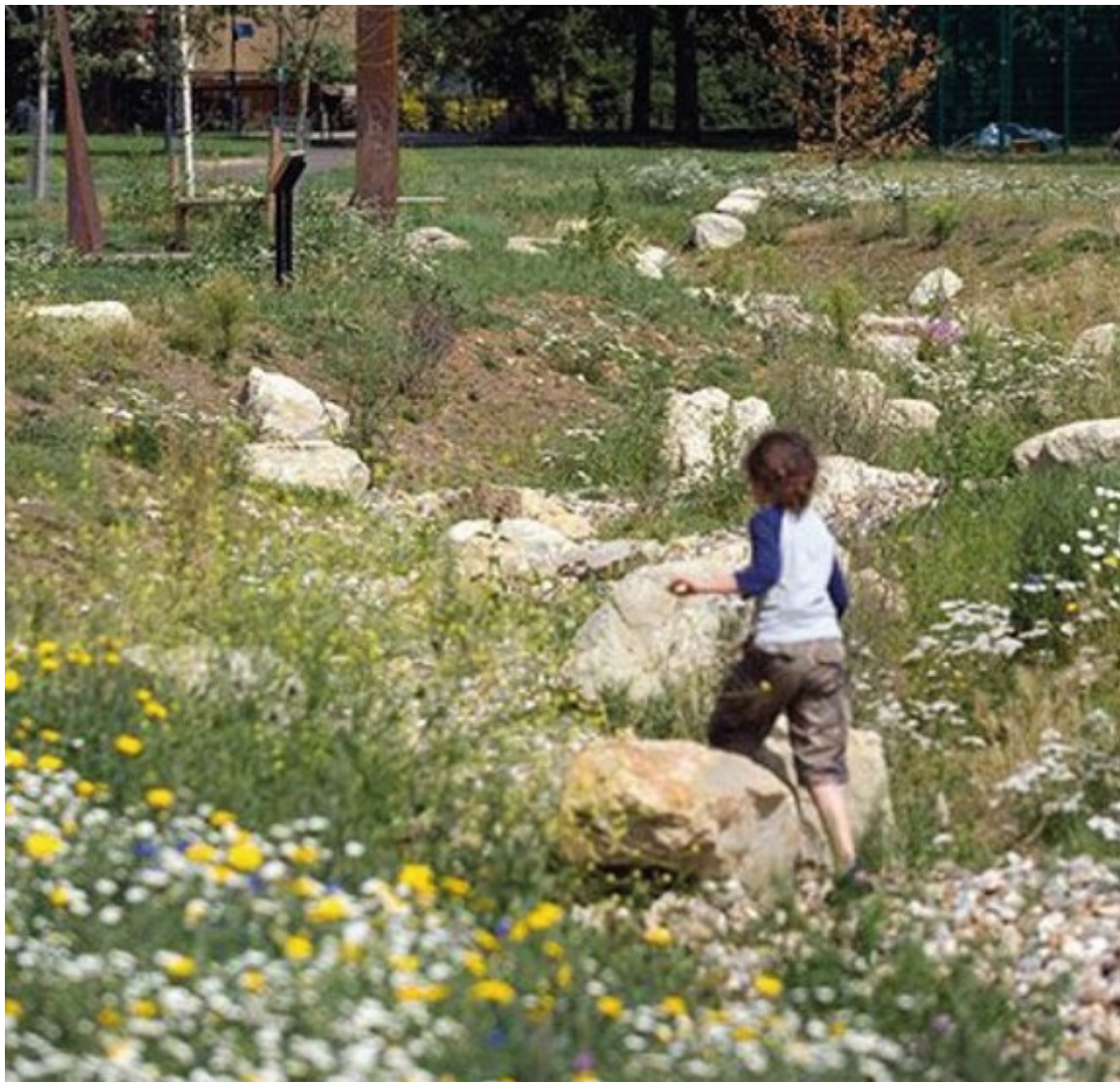
Fig. 9. Eksempel på regnvandshåndtering i planområdet. Her ses en nedsænkning udformet som et vandløb, hvor regnvand kan nedsive over tid.
